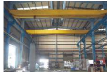
大型龙门吊 Crane
